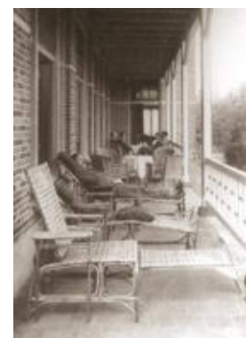
Veranda sanatorium Dennenheuvel in Ossendrecht
